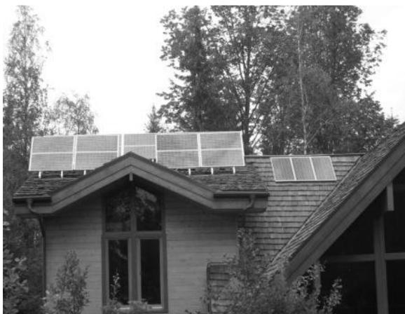
Рис. 5. Солнечная электростанция 2280-48/4,5 кВт
