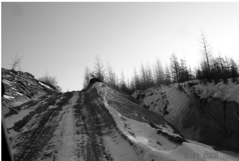
*Рис. 1.* Термоэрозионные природно-техногенные промоины по кювету автодороги
