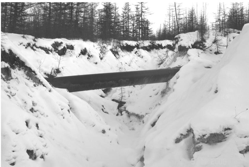
Рис. 5. «Обнажённая» труба газопровода – результат развития термоэрозии
