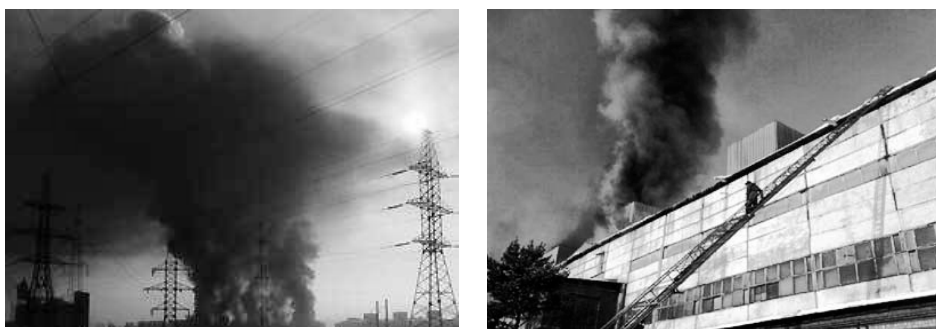
Рис. 2. Пожар на заводе «СУАЛ-ПМ»
