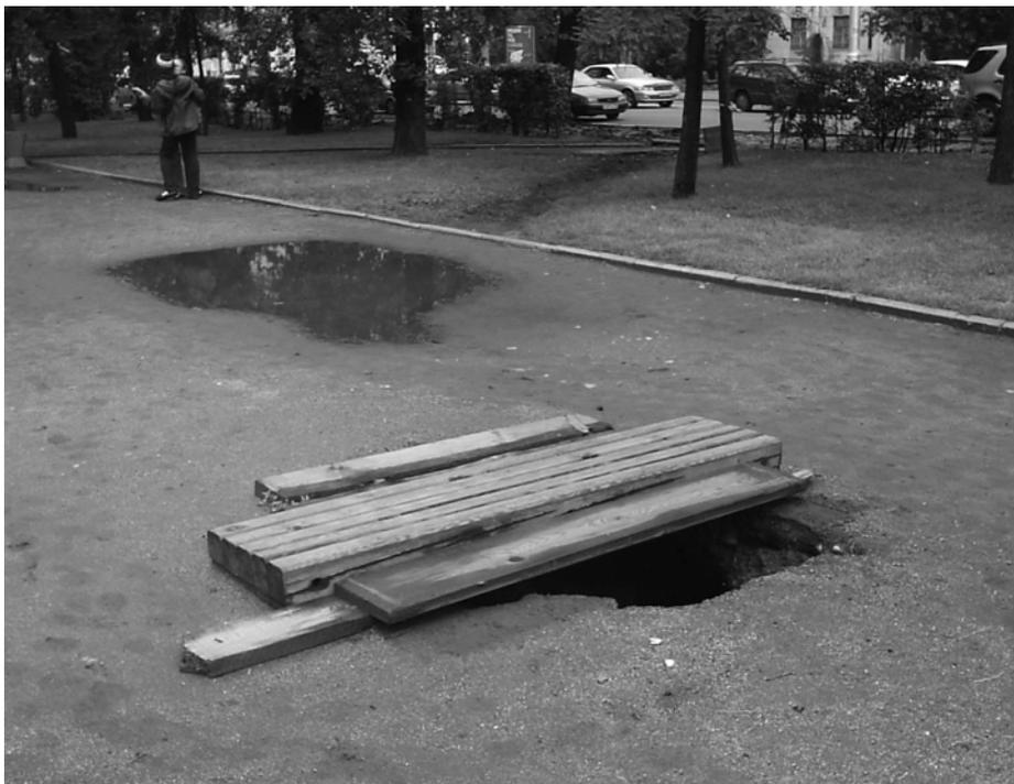
Рис. 2. Суффозионно-просадочные провалы в техногенных отложениях по ул. Ленина (центральная часть г. Иркутска)
