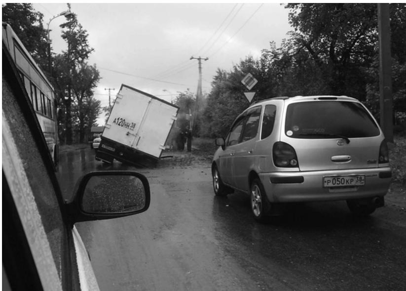
Рис. 3. Аварийная ситуация на дороге, возникшая в результате образования провала в техногенных грунтах дорожной насыпи (ул. Лермонтова, Студгородок)
