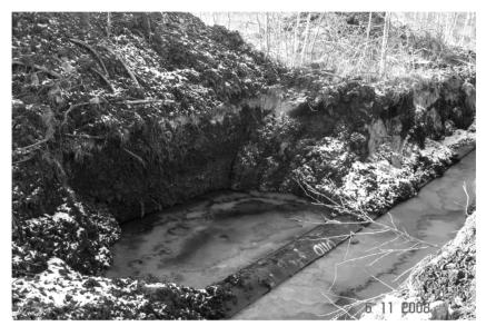
Рис. 2. Разрез слоя торфа по трассе газопровода в месте аварии
