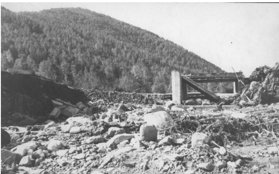
Рис. 3. Остатки моста на федеральной автодороге после прохождения селя. Южное Прибайкалье, 1971 г.
